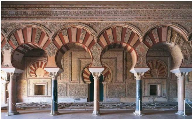
Además tiene las dovelas –‘conci’- alternadas de colores y suele estar encuadrado por un **alfiz** (se trata de una moldura que enmarca o recuadra el arco en la **arquitectura musulmana**), trasdosado y con el despiece (‘sezionamento’) de las dovelas a la línea de impostas
