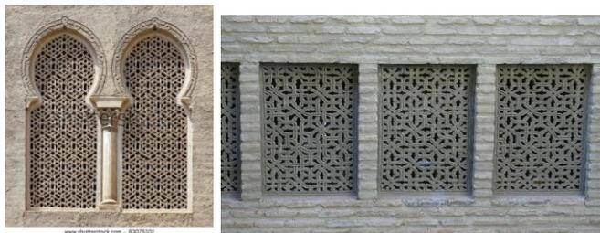
En la Alhambra se emplea un tipo de **columna** propio que no aparece en ninguna otra construcción. Es una columna de fuste cilíndrico muy fino, con una base que presenta una gran **moldura cóncava** ('modanatura, cornice'), y adornada por anillos en su parte superior.
