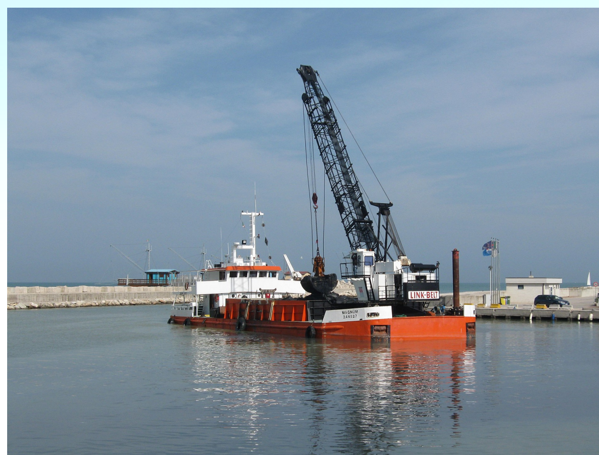
Un battello-draga in azione durante lavori di escavazione del porto di Fano .
