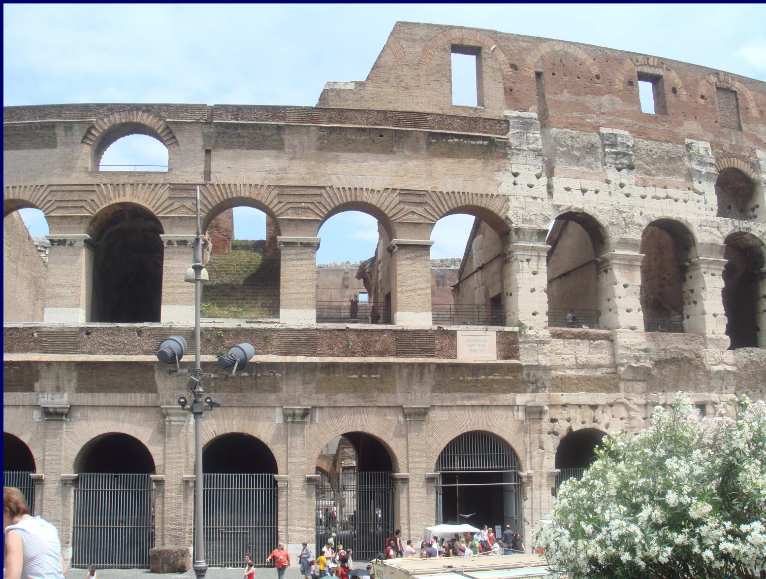
Roma, Colosseo, sec. I, contrafforte meridionale Intervento di Gregorio XVI (18??).
