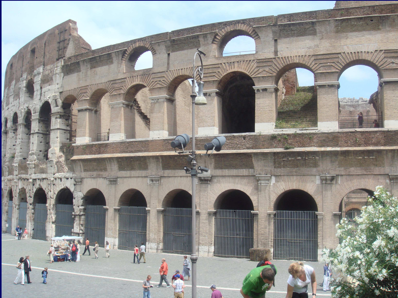
Roma, Colosseo, sec. I, contrafforte meridionale Intervento di Gregorio XVI (1831-46).
