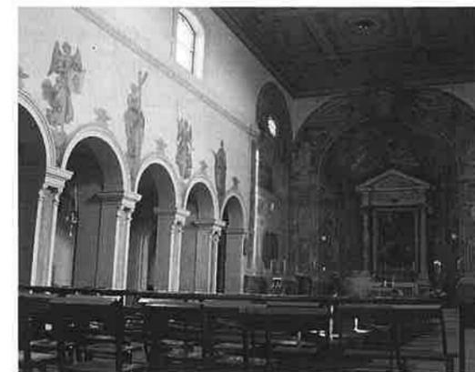
FIGURA 3 • Roma, Santa Pudenziana, veduta interna. La "ristrutturazione", che si inizia nel 1588, segue la strada dell'"aggiornamento"; le colonne sono racchiuse in nuovi sostegni murari e la conca dell'abside viene tagliata per realizzare la cupola (Francesco da Volterra, 1588). Ciò apporta una menomazione al mosaico (IV secolo), che perde due dei dodici apostoli.
