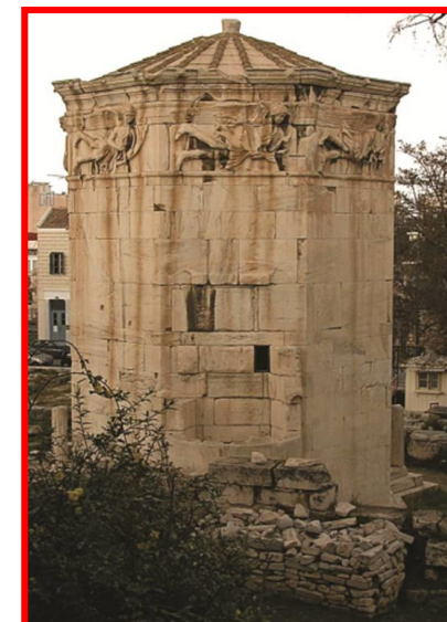
Torre dei venti
