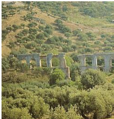
Termini Imerese: acquedotto
