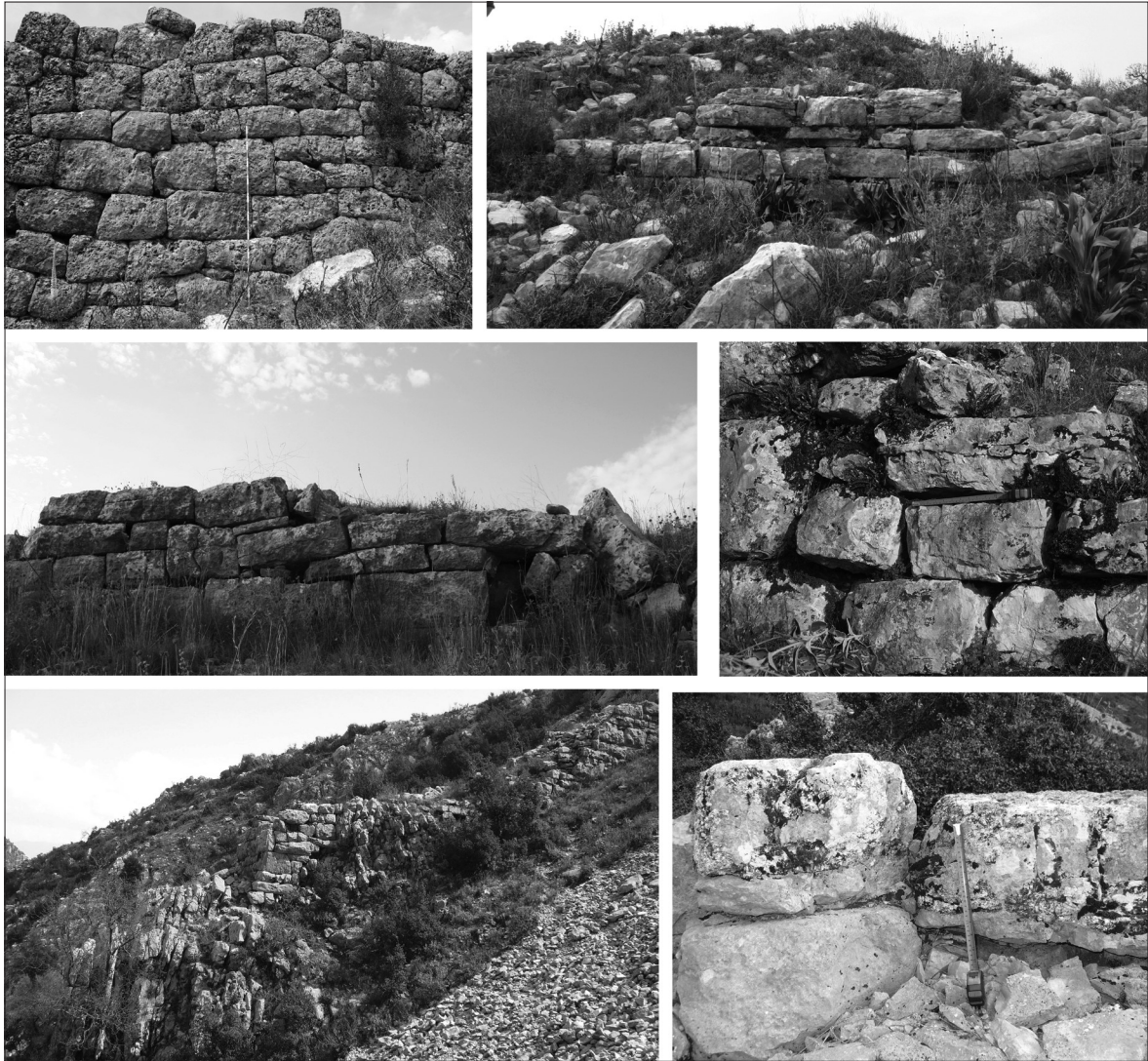
Fig. 13. Some cases of irregular trapezoidal masonry: Ripësi, Paleomanastiri, Malçani, Shën Gjini, Selo, Duka.
