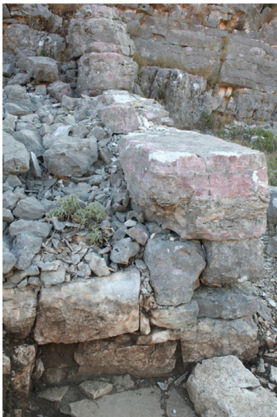
Fig. 4 - Muro realizzato in opera quadrata nell'insediamento presso Paleospiti di Frashtan.
