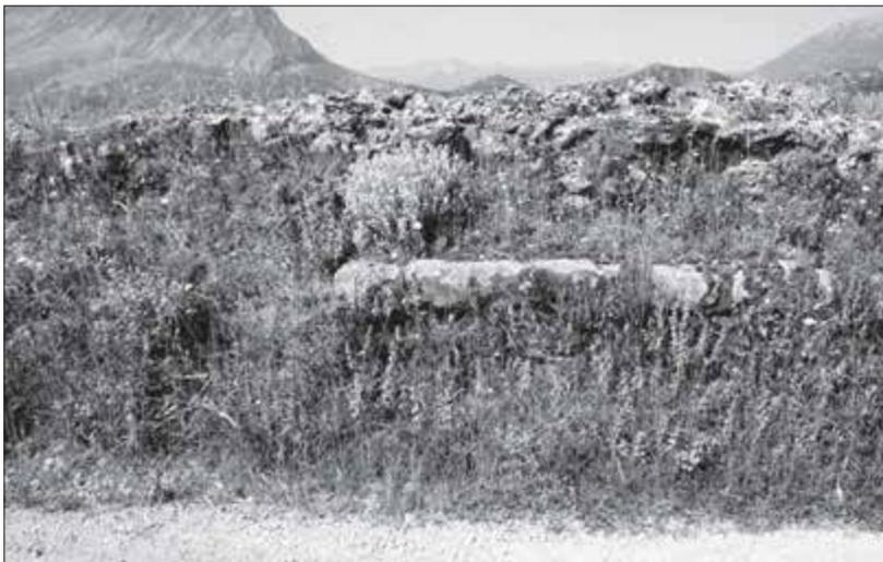
Fig. 74. - Paleokastër, particolare del tratto delle mura edificate in blocchi quadrati di reimpiego.
