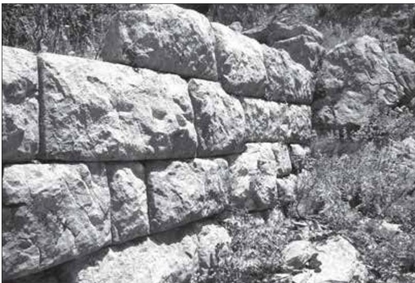
Fig. 55. - Selo, paramento esterno di una delle torri, in grandi blocchi calcarei disposti in opera rettangolare.
