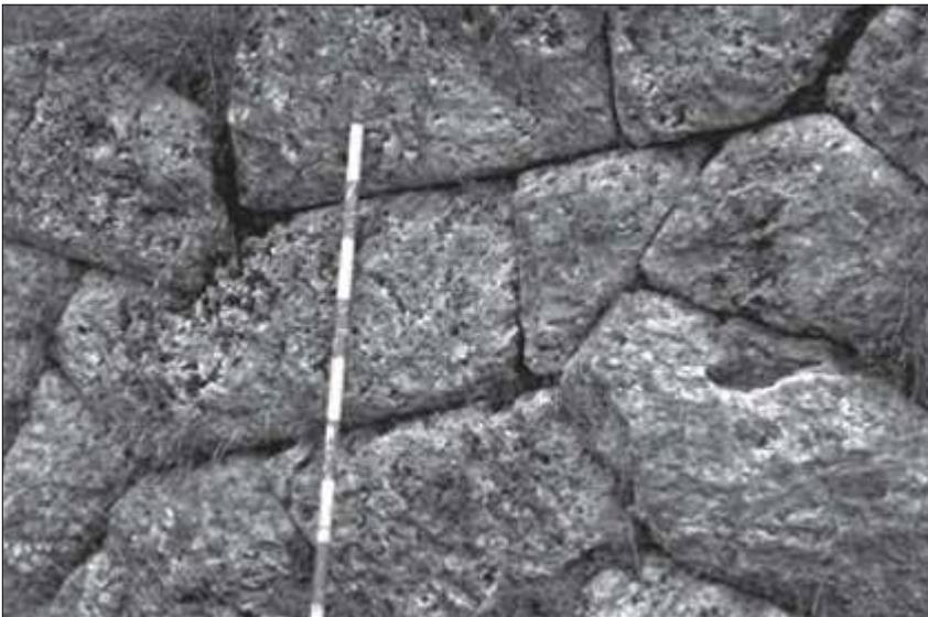
Fig. 65. - Melan, particolare di un tratto delle mura di cinta della fortificazione in opera poligonale.
