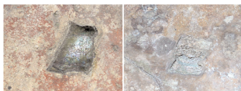
Fig. 70 - Cappella B, parete N: due tessere vitree inserite nell'intonaco
