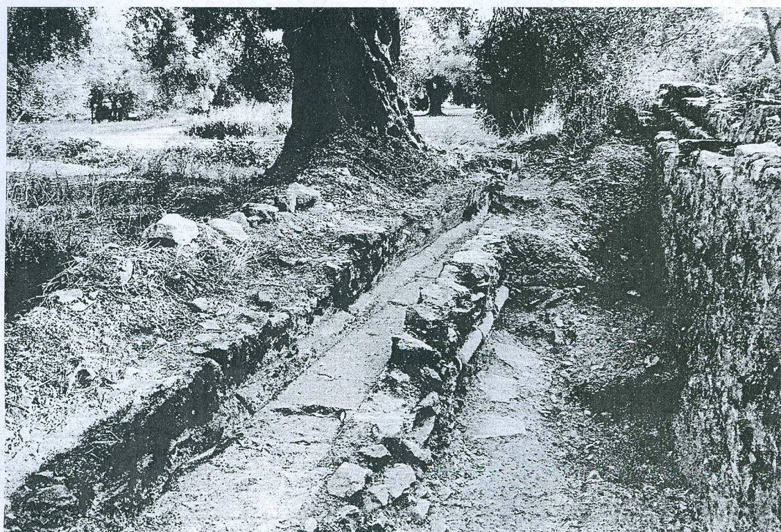
FIG. 68 – IL RAMO B DELL'ACQUEDOTTO: LO SPECO E IL PRECEDENTE CONDOTTO IN TERRACOTTA.
