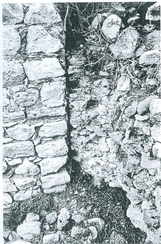
FIG. 64 – PARTICOLARE DELLA STRUTTURA IN MATTONI INGLOBATA NEL CASTELLUM AQUARUM N. 35.
