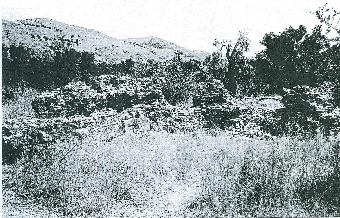
FIG. 69 – ESEDRA IN MATTONI CON BOCCHIE DI FONTANA FACENTE PARTE DEL PROBABILE COMPLESSO TERMAL E ALIMENTATO DAL RAMO B DELL'ACQUEDOTTO.
