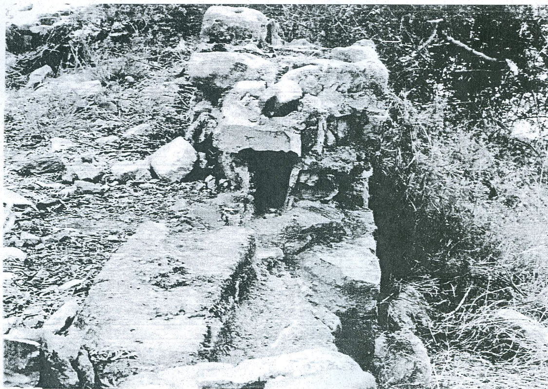
FIG. 61 – PARTICOLARE DEL TRATTO SEZIONATO DELLO SPECO DEL RAMO A DELL'ACQUEDOTTO (CFR. FIGG. 59, 60).
