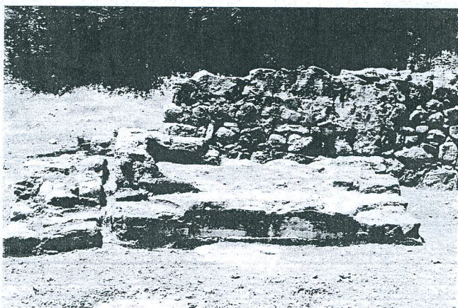
FIG. 38 – VEDUTA DELL'INTERNO DELLA FONTANA N. 6. SONO BEN EVIDENTI LE TRE FASI COSTRUTTIVE.
