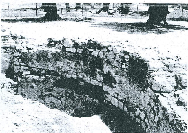
FIG. 38 – VEDUTA DELL'INTERNO DELLA FONTANA N. 6. SONO BEN EVIDENTI LE TRE FASI COSTRUTTIVE.
