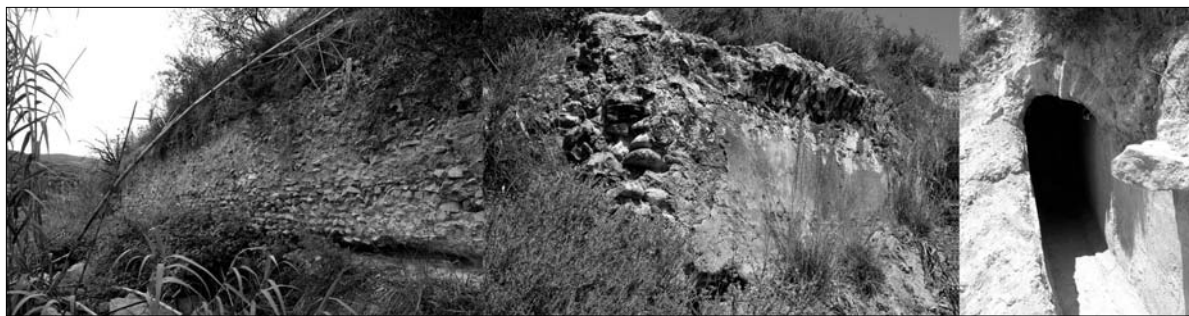
Fig. 9. La struttura dell'acquedotto: un tratto della struttura esterna in conglomerato e due dettagli dello speco con la copertura voltata.
