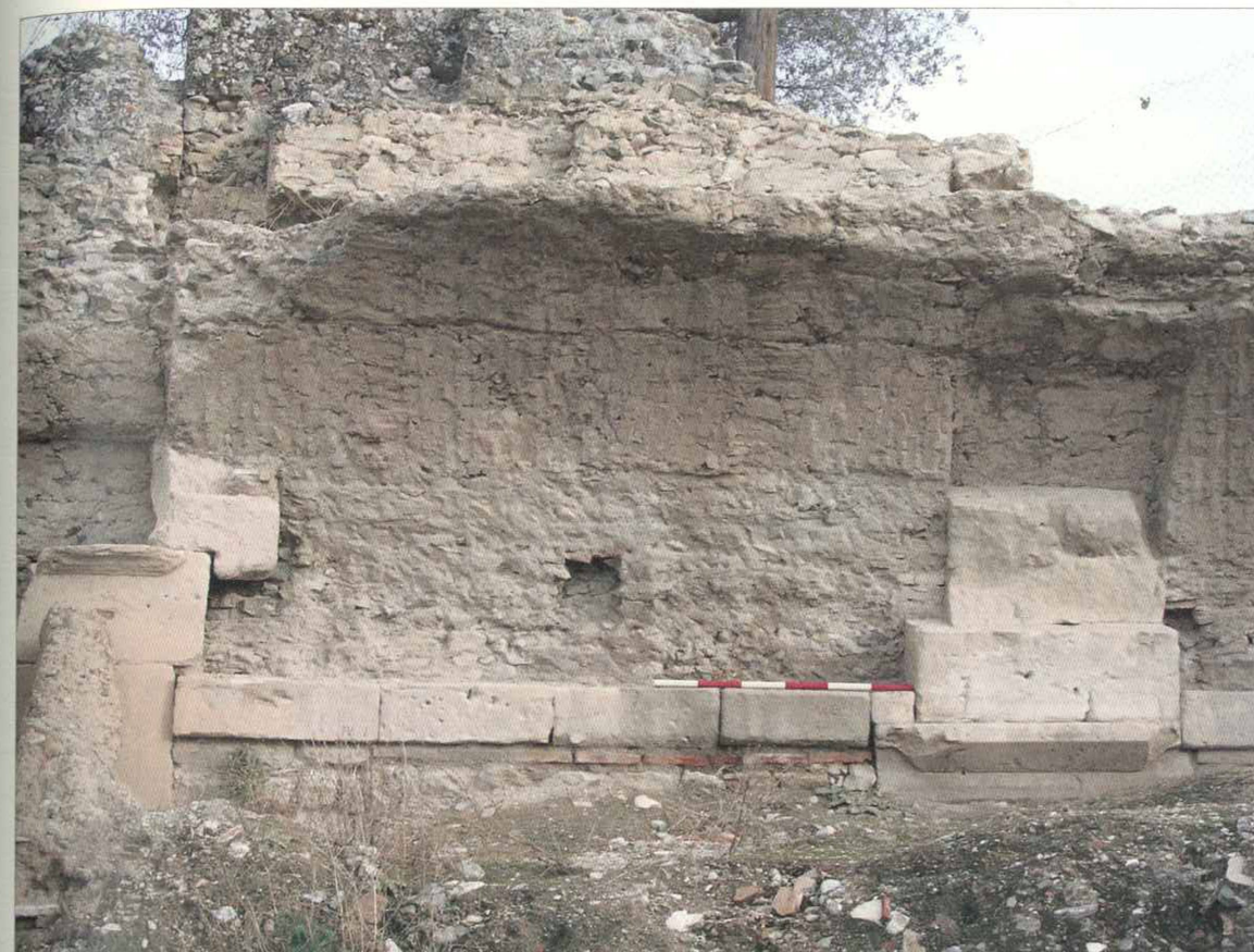
Fig. 102. Il segmento a cortina laterizia compreso tra le prime due nervature in blocchi lapidei sul lato orientale del corridoio sostruttivo curvilineo del piano terra.
