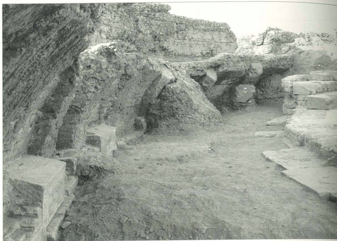
Fig. 101. Il corridoio sostruttivo curvilineo della cavea.
