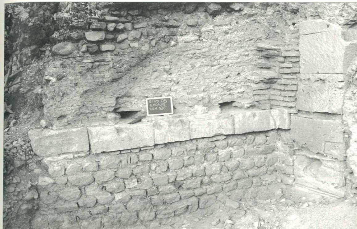
Fig. 106. Resti di una volta a botte conoidica con imposte orizzontali (camera 12).
