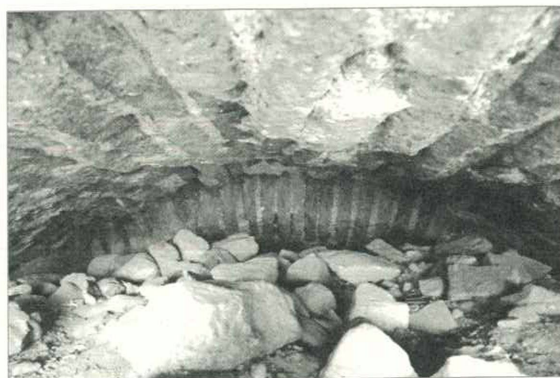
Fig. 104. La doppia ghiera sfalsata in laterizio all'interno del corridoio assiale.
