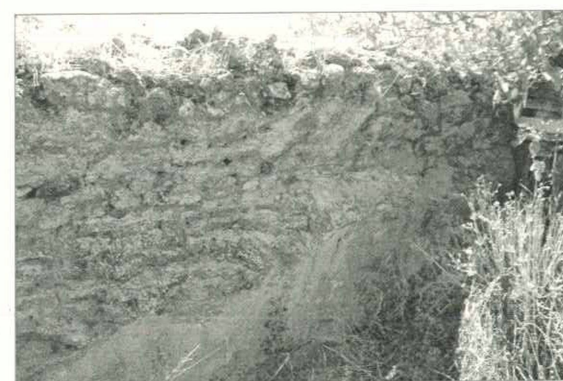
Fig. 114. Impronte della cortina laterizia sull'intradosso delle volte delle cisterne monumentali ad Haghia Photià.
