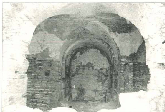
Fig. 120. Volta composta impostata su pilastri nelle cosiddette terme del Leonidaion a Olimpia.
