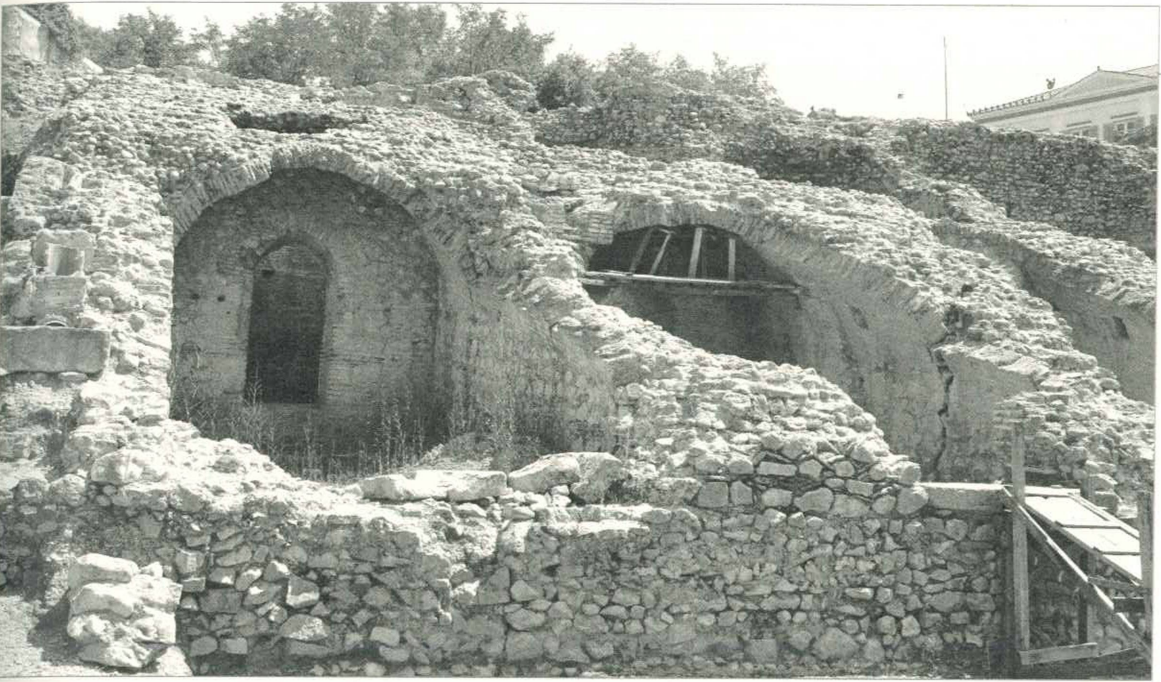
Fig. 117. Veduta delle sostruzioni N nello stadio di Patrasso con volte in laterizio.
