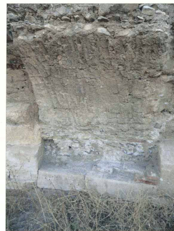
Fig. 103. Le tracce della differente tessitura dei laterizi visibili in traccia sull'intradosso del corridoio sostruttivo curvilineo della cavea: ad un settore inferiore a laterizi disposti parallelamente si sovrappone una cortina realizzata a tessitura trasversale.
