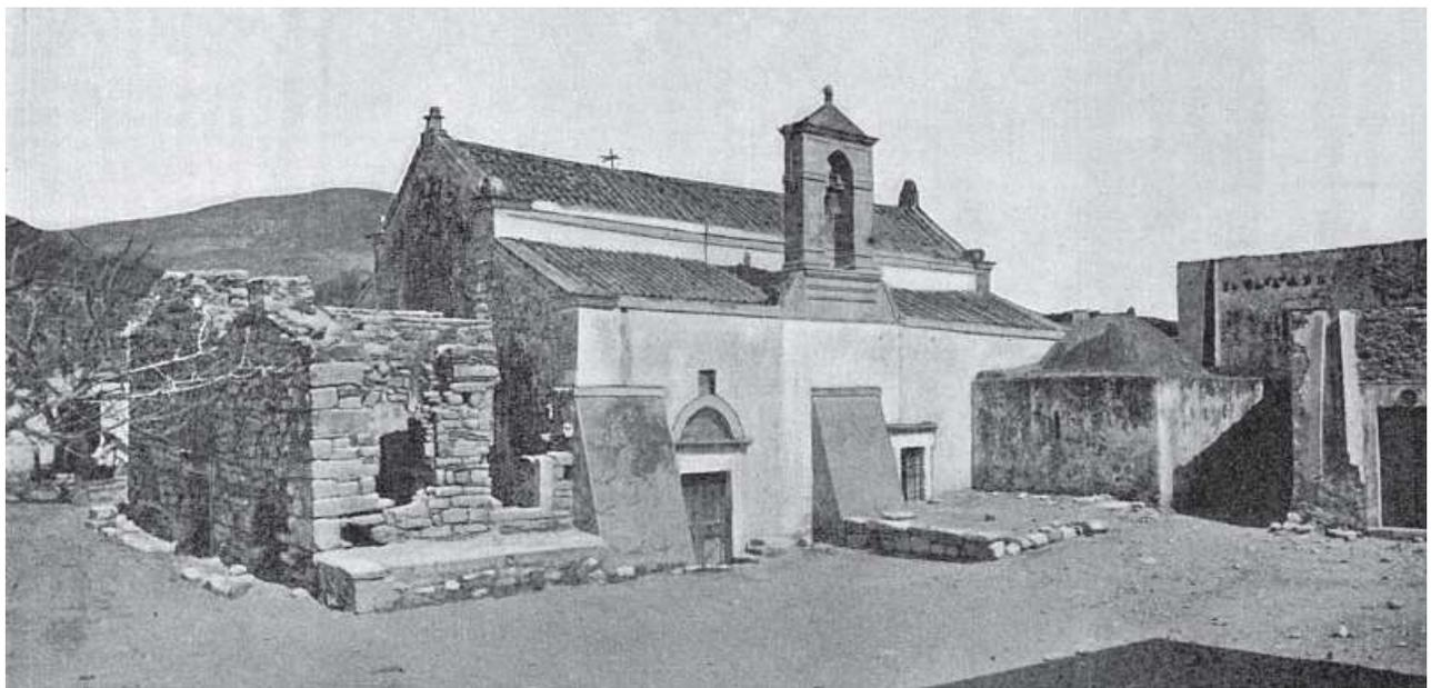
Fig. 439 – Haghii Deka, la chiesa dei Santi Dieci nel 1900, da Sud-Ovest (GEROLA 1908, p. 187, fig. 128). È ancora in piedi, anche se scopercchiato, l'antico narcece tripartito e l'ingresso meridionale rende evidente il forte dislivello con il piano di calpestio moderno.
