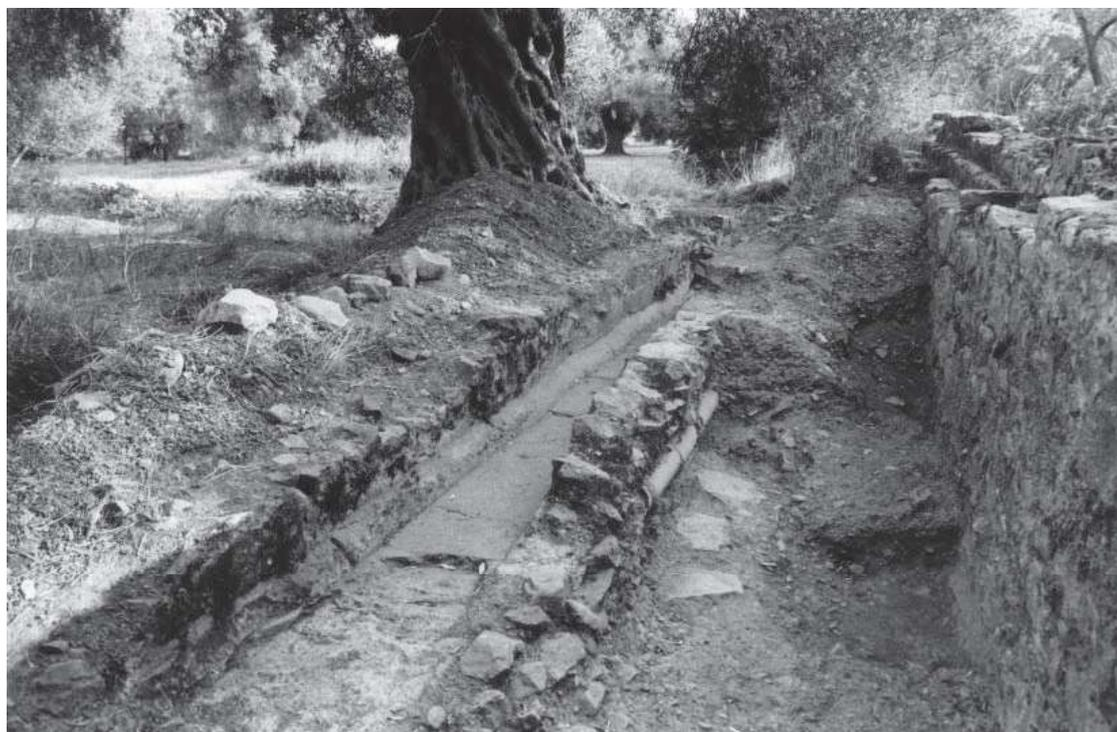
Fig. 336 – Gortina, acquedotto, ramo B: una veduta parziale da Nord. Questo ramo portava acqua a pressione, aveva un piano di bipedali e correva fra due muri che lo contenevano in uno spazio di 10 piedi romani; III-IV sec. d.C.
