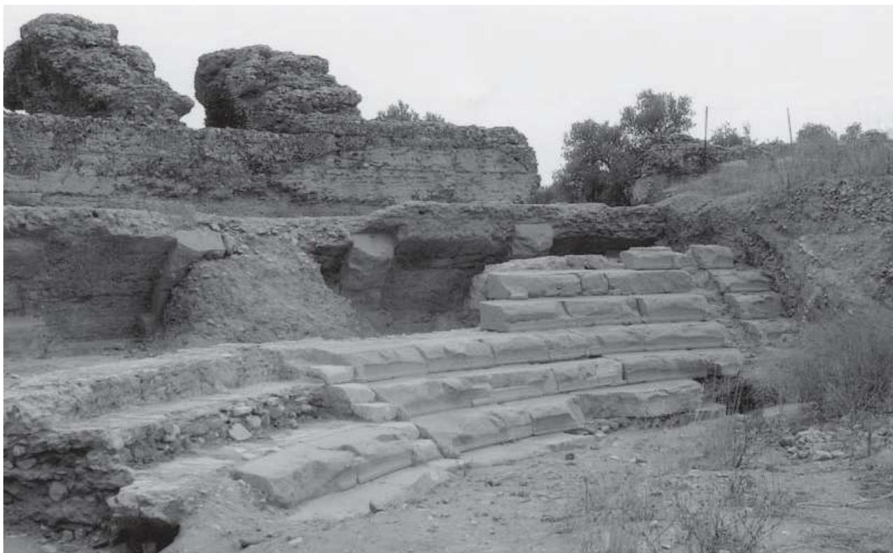
Fig. 421 – Gortina, odeion del Pythion. Le nervatura a blocchi che scandiscono il muro ad emplecton dell'ambulacro che sopportava l'ima cavea (foto dell'A.).
