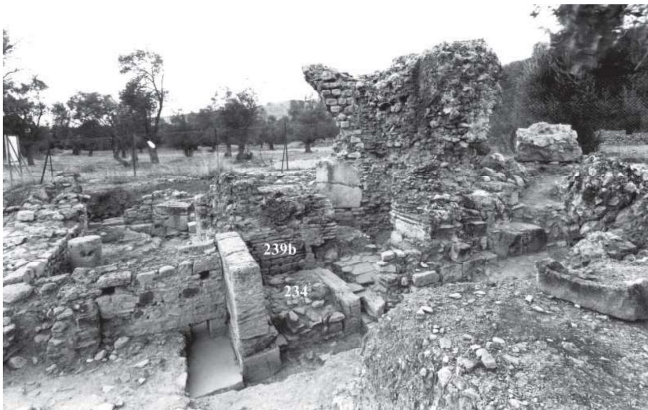
Fig. 344 – Gortina, fontane tarde a ridosso dei piloni 231, 242, 243 dell'acquedotto C, ove l'acqua continuò a scorrere anche dopo la fine della città. In primo piano la fontana più antica (234) con per prospetto un ortostate di cipollino cui segue il lato est del basamento 239 b.
