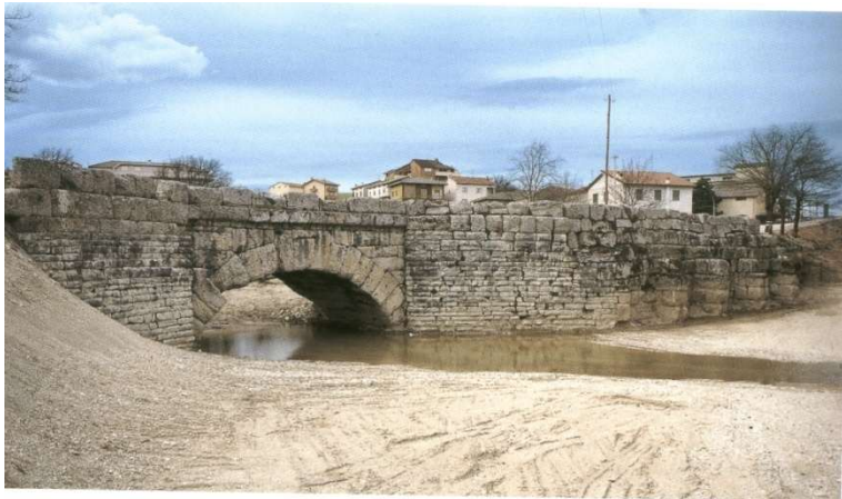
Flaminia, Ponte Manlio
