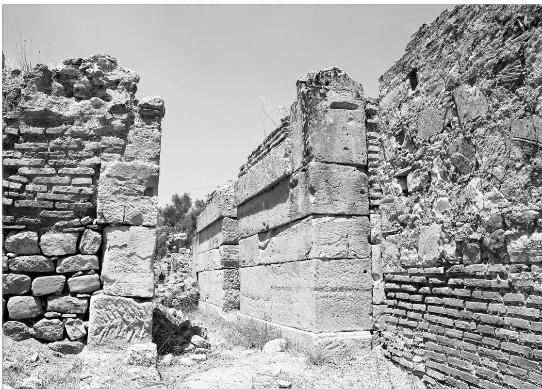
Fig. 4. Gortina, muro in blocchi isodomi presso il triconco.
