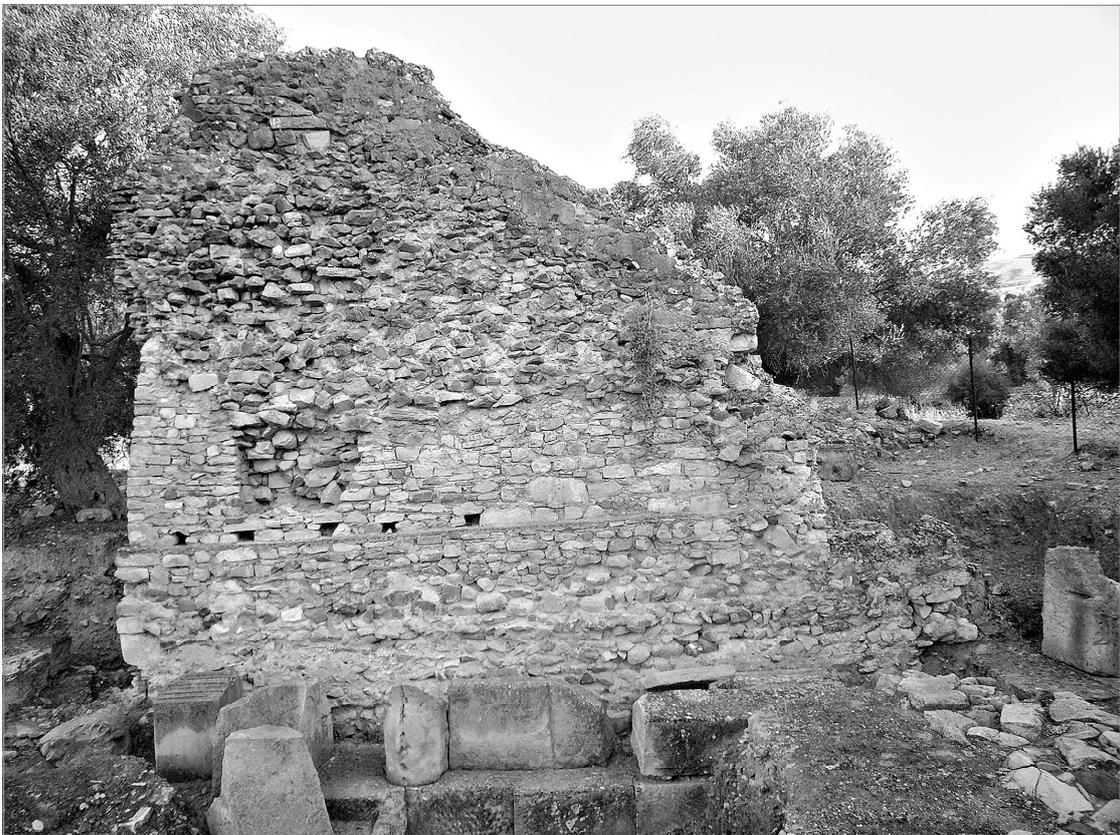
Fig. 51. *Caput aquae* del Pretorio: lato E. Nella parte inferiore, al di sotto dei restauri del Colini, si notano delle fondazioni appartenenti ad una struttura più antica (fase I).
