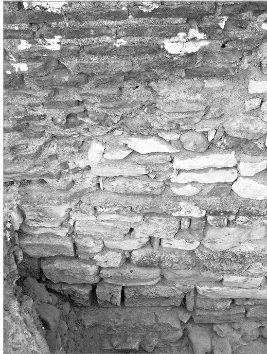
Fig. 52. *Caput aquae* del Pretorio: lato O, estremità meridionale. Nella parte inferiore, al di sotto dei restauri del Colini, si notano le fondazioni appartenenti ad una struttura più antica (fase I), composta da tre filari di blocchi sormontati da una lastra di arenaria (US 3303).
