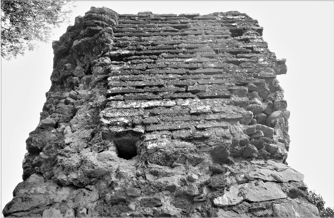
Fig. 50. *Caput aquae* del Pretorio: lato S. Resti di un piccolo vano o cavo, rivestito in mattoni e interpretato come spazio per sostenere una vaschetta in piombo e alloggiare le tubazioni.
