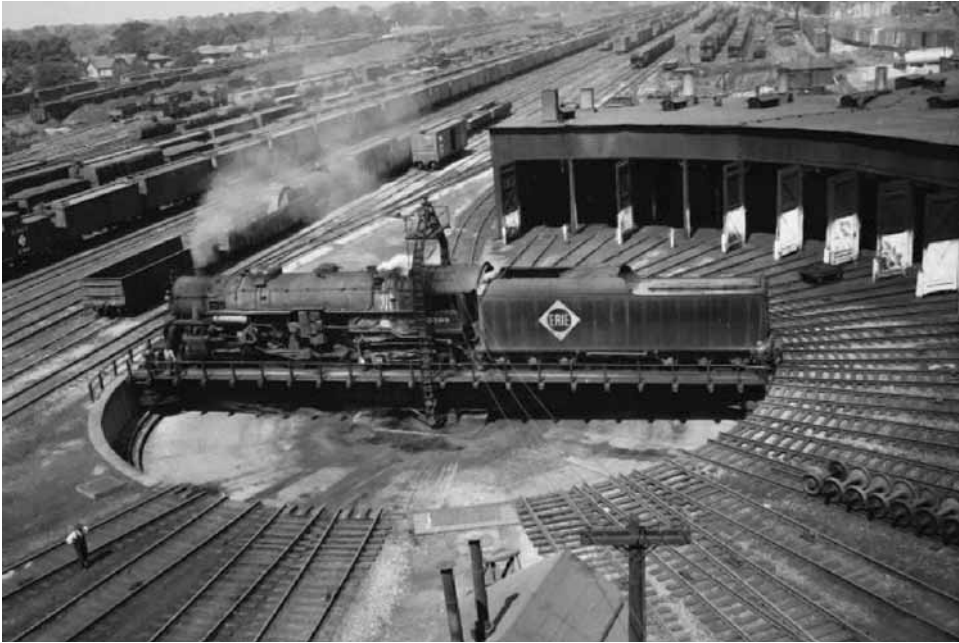
Fig. 16 - Una delle due roundhouses di Salamanca (NY) che consentivano con movimento rotatorio il collegamento tra la Erie Railroad e la Atlantic & Western Railway (Erie Railroad, 1947)
